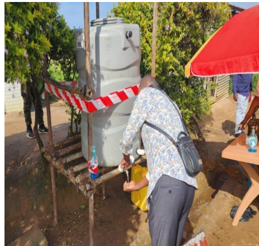
Installation d'un point de lavage des mains au PoC
