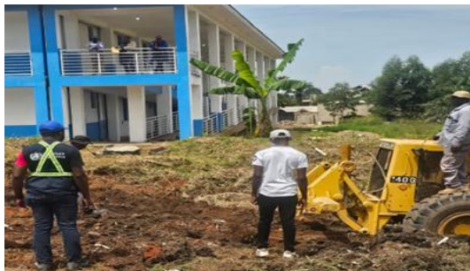
Poursuite des travaux d'aménagement du CTE Rwampara
