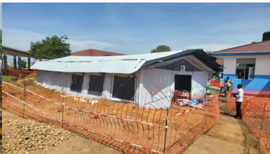
Finalisation d'installation de deux tentes de prise en charge à l'HGR Bunia (avec 8 chambres et 8 toilettes)
