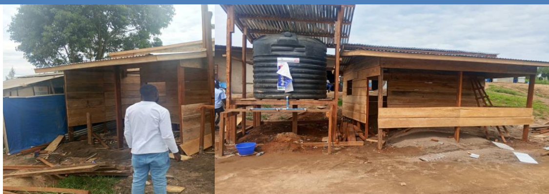
Début de construction des cabanes et installation de point de lavage des mains au PoC Dele, province de l'Ituri.
