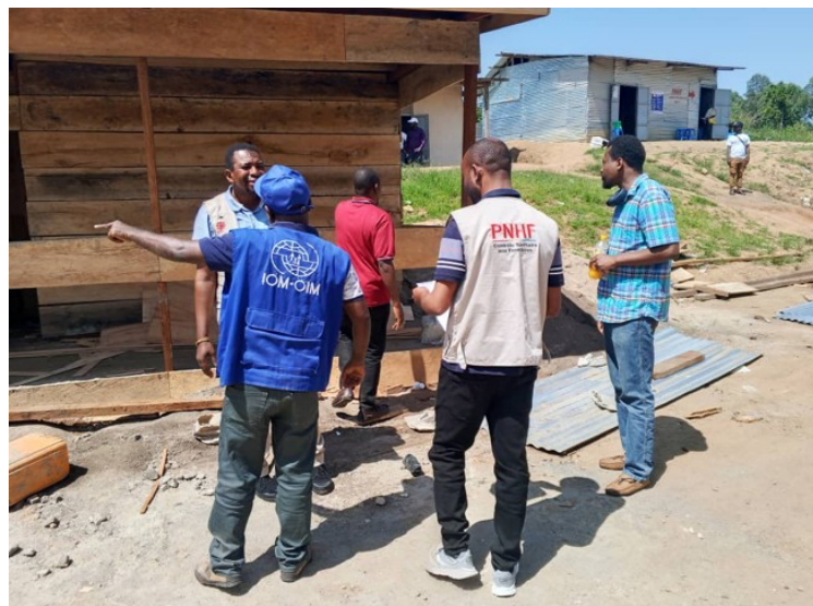
Supervision de travaux de construction de la cabane de PoC Dele dans la zone de Santé de Rwampara
