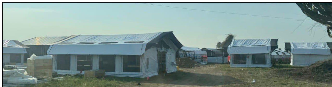
Installation et lancement des activités du laboratoire de diagnostic à Kasenya dans la zone de santé de Tchomia en Ituri
